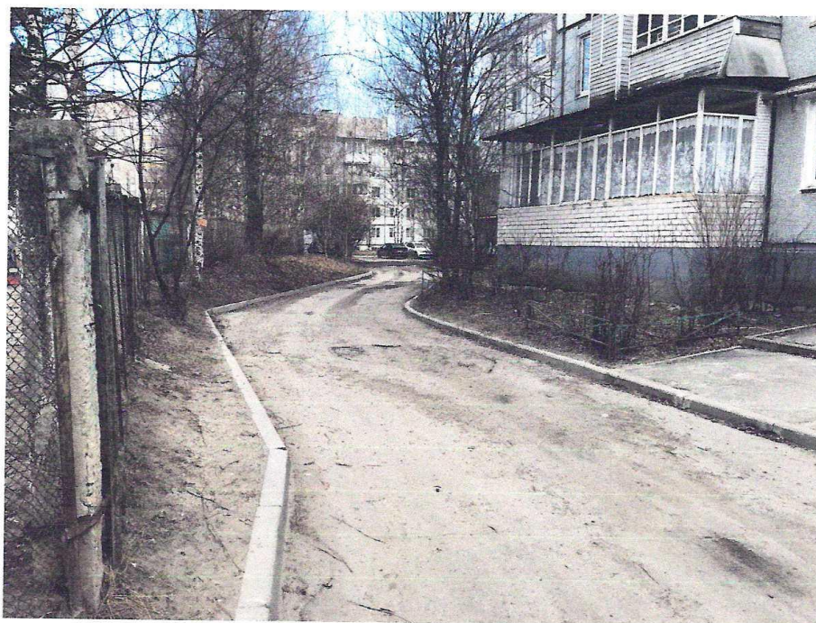
Движение по проезжей части вдоль дома по ул. Псковская 9Д (отсутствие тротуара)
